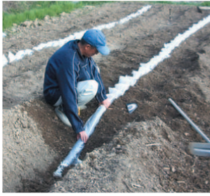
パイプの埋設作業(4月)
